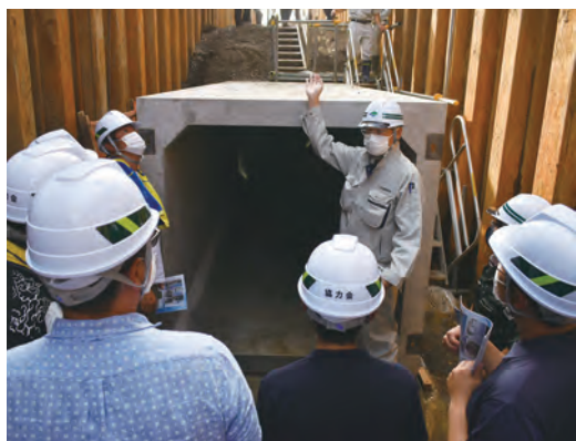
地下5mにある導水路を間近で視察
